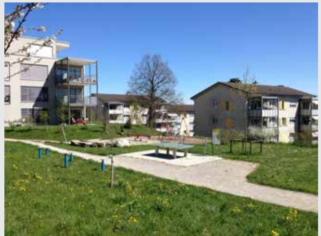
Pilotgebiet Hochstrasse, Schaffhausen
